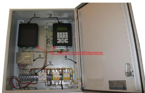
Рисунок 1 - Общий вид блока измерительного ИС-14.М
