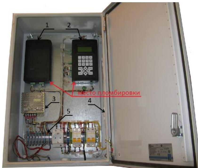
Рисунок 1 – Внешний вид блока измерительного ИС-14
